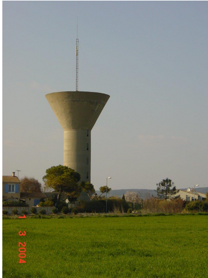
Photo 3 - Château d'eau de Vic-La-Gardiole
